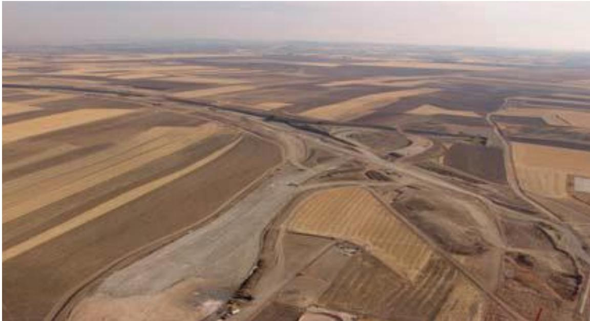
Proyecto de ampliación de la autopista AP-7. Construcción de un tercer y cuarto carril por calzada entre el nuevo enlace de Fornells y el nuevo enlace de Vilademuls.
